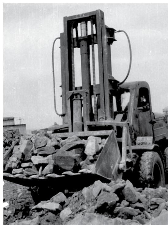
Рис. 5. Горелая порода на складе сырья и доставка ее к щековой дробилке
